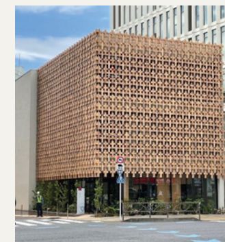
外装に多摩産材のスギを使用するなど地産地消にも貢献
